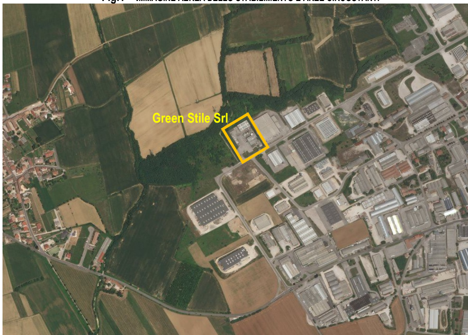
Fig.1 – IMMAGINE AEREA DELLO STABILIMENTO E AREE CIRCOSTANTI
